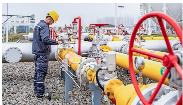
内江公司排查输气管道隐患
