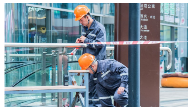
苏州公司开展商业综合体燃气泄漏爆燃及消防安全疏散演练
